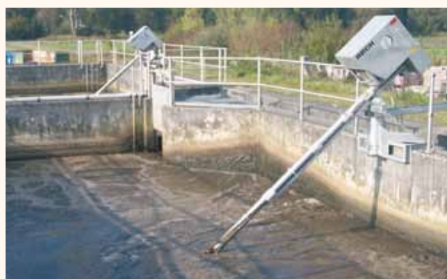
Elektro mešalo s stacionarno namestitvijo za odprte gnojnične bazene (Art. št.: ETR-HS)
